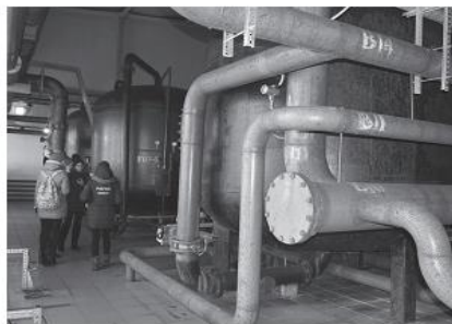
Фильтрация воды через песок и активированный уголь
