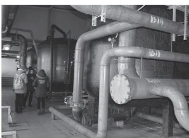
Фильтрация воды через песок и активированный уголь
